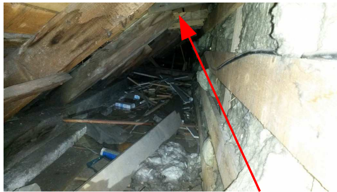
Foto 14: Pohled na krov (ST2) - ukončení krokví v místě rizalitů
