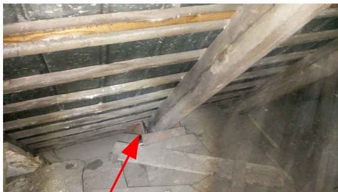
Foto 13: Původní zesílení pomocí ocelových prvků
